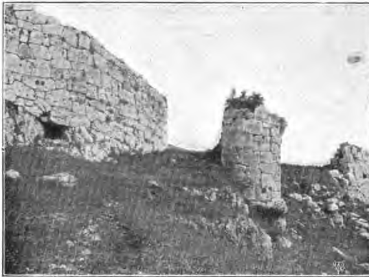
Fig. 15. — Murs de Norba (Norma d'aujourd'hui), pays des Volsques, dans le Latium. Entrée principale.
